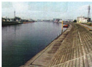
写真 2-2-2 下流部のコンクリートと矢板の護岸（6k付近）
