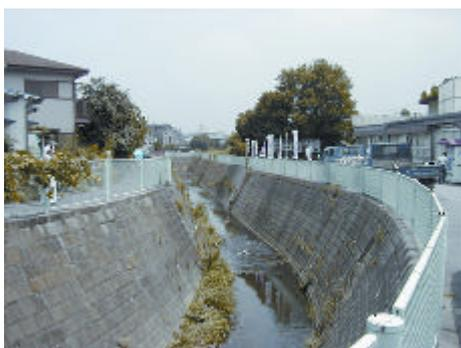
写真 2-1-4 コンクリートブロック護岸 (支川)
