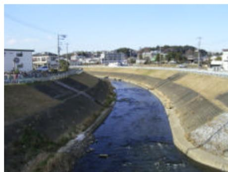
写真 2-1-5 コンクリートブロック護岸 (本川)
