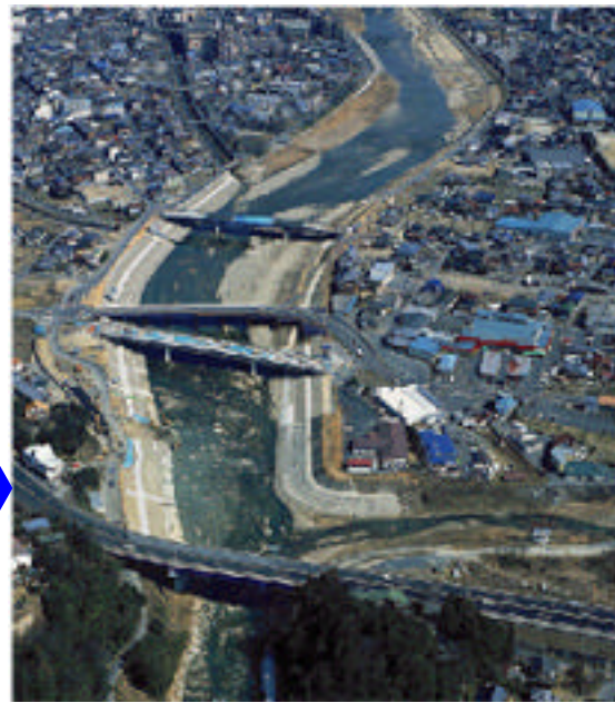
(対策後 平成16年3月撮影)
