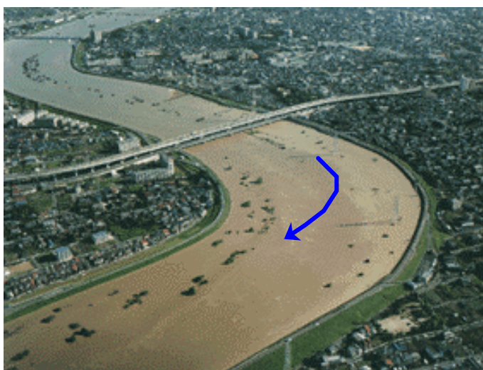
万場大橋(河口から約 9.0k)付近の状況
