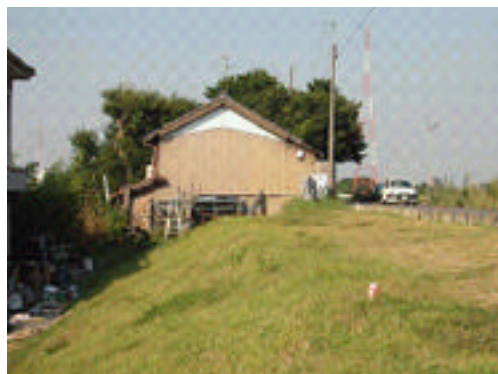
図-4.23 高水敷上の占用家屋
