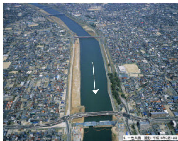
一色大橋 (4.5k 付近)
