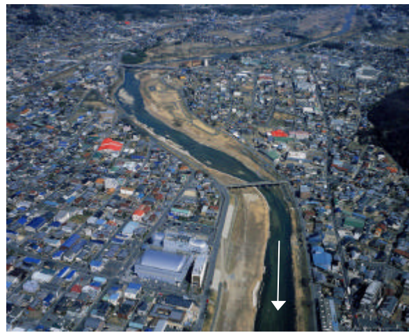
土岐市の盆地部を流下する庄内川 (58.0k 付近)
