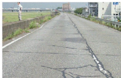
図-7.18 クラックが入った状況
