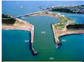
導流堤による水戸口(河口部)の維持
