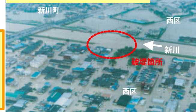
新川の破堤氾濫による浸水状況
