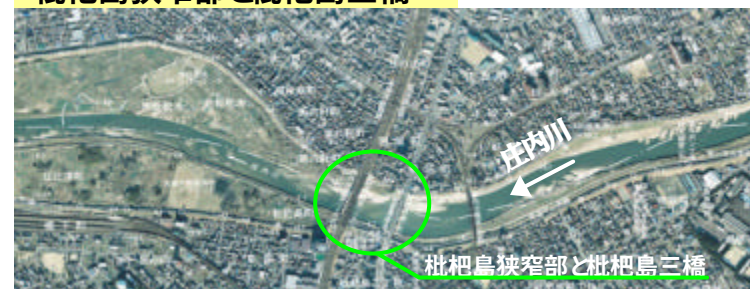
枇杷島狭窄部と枇杷島三橋
