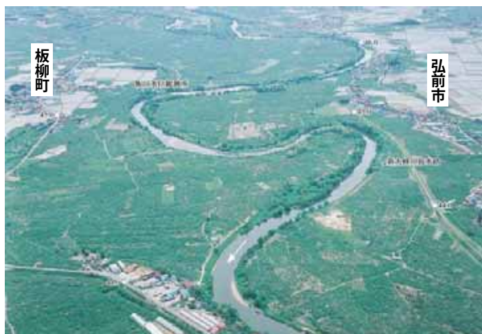
【44.0k 付近の河道の状況】
