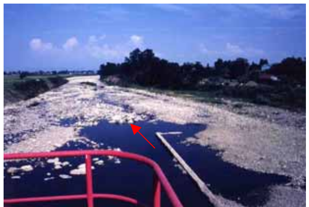
統合頭首工（平成8年） （出典：津軽ダム工事事務所）
