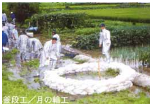
釜段工／月の輪工
