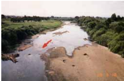
幡龍橋上流地点 (岩木川 43.0km 付近)
