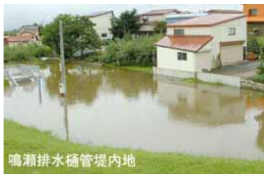
鳴瀬排水樋管堤内地
