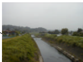
寺家橋付近 28km 上流側)
