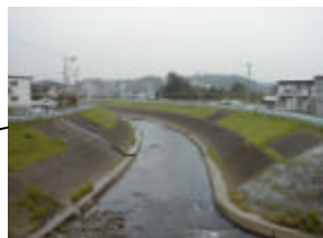
水車橋付近 29km 上流側)
