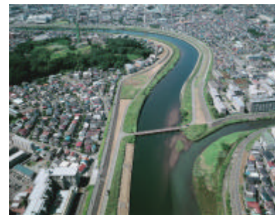
写真 2-2-3 支川早淵川合流部に形成された洲
