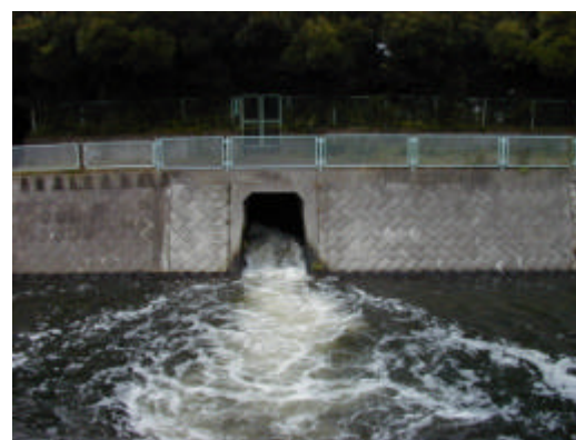
写真 6-3-1 成瀬クリーンセンター (町田市)からの 放流状況 (出典：京浜河川事務所)
