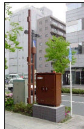
写真 9-3-1 浸水検知センサー（新横浜駅周辺）
