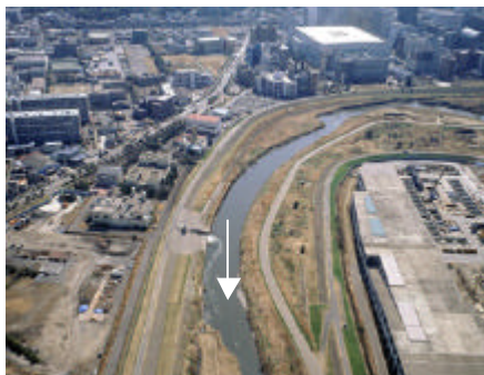
写真 2-1-6 オギ・ヨシの繁茂している高水敷 出典 :京浜河川事務所
