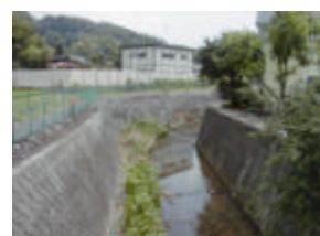
桜橋付近 29km 上流側)
