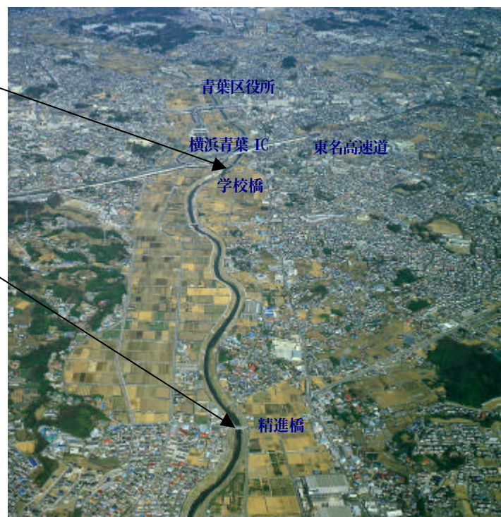
【20km 付近から上流の河道の状況】
