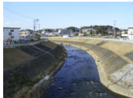
写真 2-1-5 コンクリートブロック護岸 (本川) 出典 京浜河川事務所
