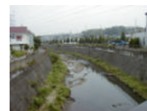
下川戸橋付近 23km 上流側)
