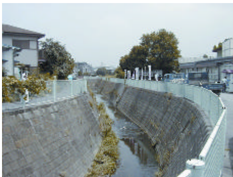
写真 2-1-4 コンクリートブロック護岸 (寺家川) 出典 京浜河川事務所
