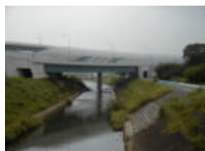
学校橋付近 23km 上流側)
