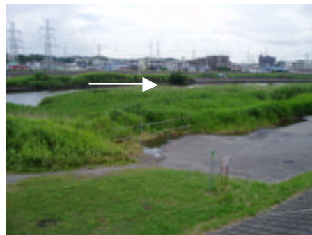
写真 2-1-7 オギ・ヨシの繁茂している高水敷 出典 :京浜河川事務所
