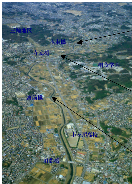
【25km 付近から上流の河道の状況】
