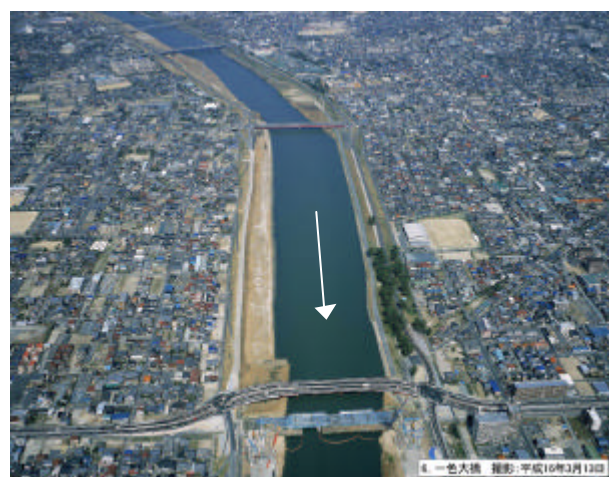
一色大橋(4.5k 付近)
