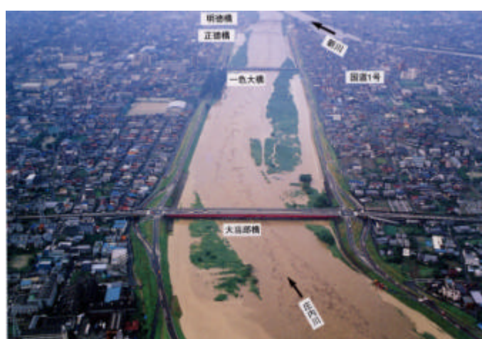
一色大橋(河口から約4.4km)付近(名古屋市中川区)の状況
