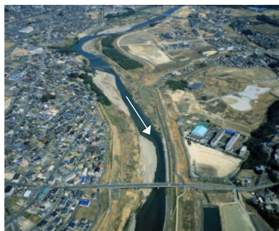
野添川合流付近(33.0k 付近)
