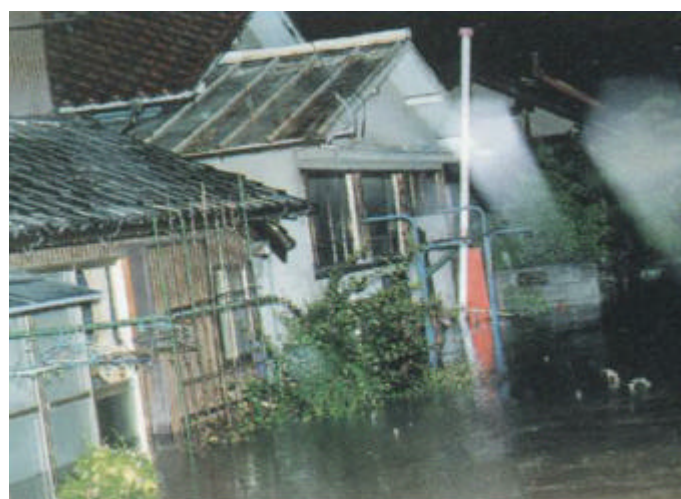
土岐市内の浸水状況
