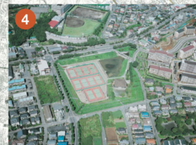
霧ヶ丘調整池(防災調整池)
