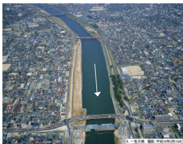
一色大橋 (4.5k 付近)
