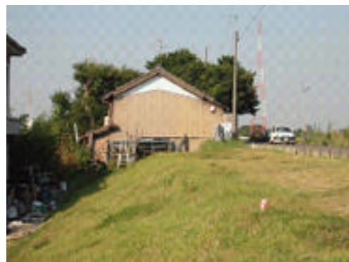
図-4.23 高水敷上の占用家屋
