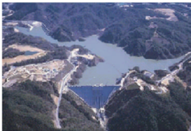
図-4.28 小里川ダム
