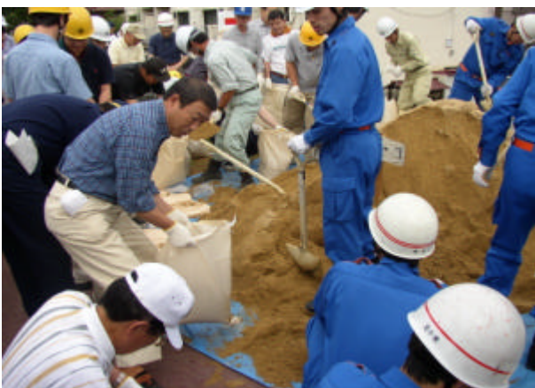
参加者による土嚢作成状況
