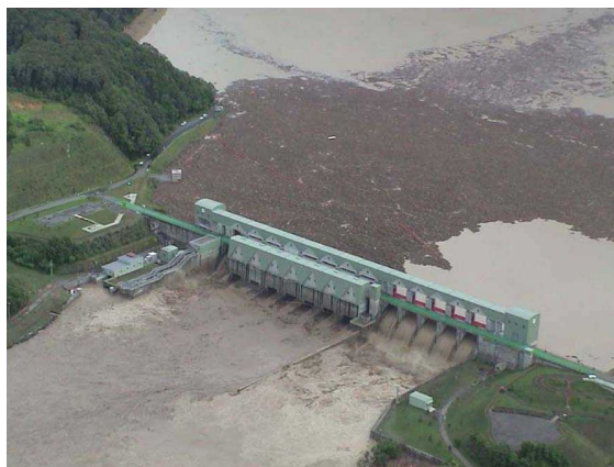
二風谷ダム下流から放流状況
