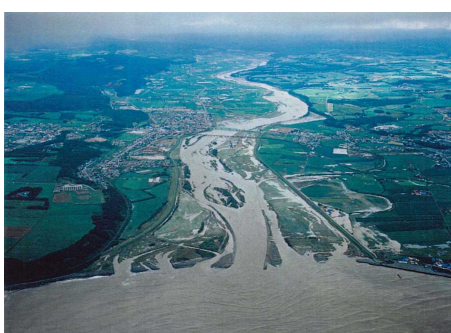
沙流川河口 出水状況
