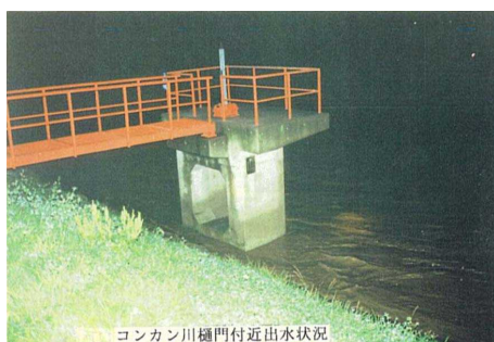
コンカン川樋門付近出水状況
