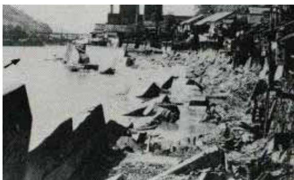
国道が流出した吉野町 よしの 上市 かみいち 付近
