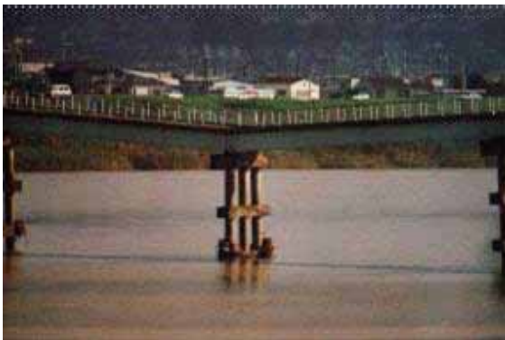
南海橋の陥没被害
