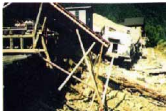
倒壊した木工センター (川上村東川付近)
