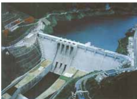
大滝ダム本体
