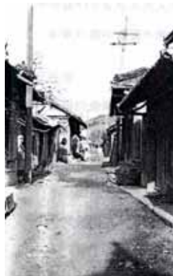
上様堤：伊都郡三好村三谷地先 （現伊都郡かつらぎ町三谷）
