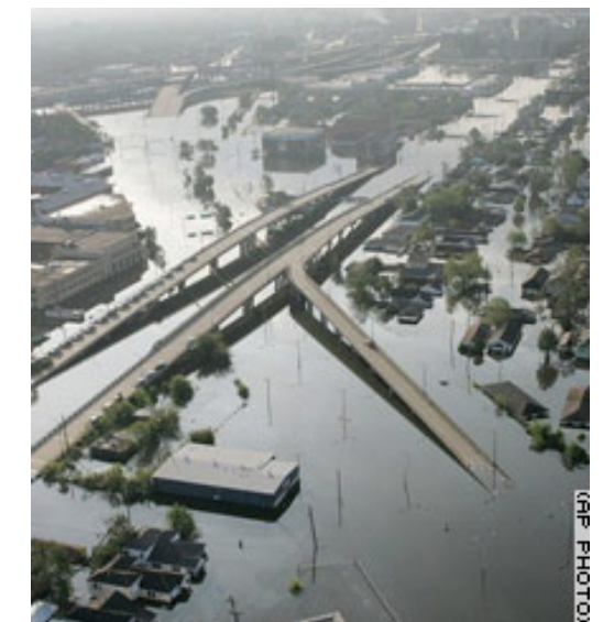
街の中心地近くの通りが浸水 4)
