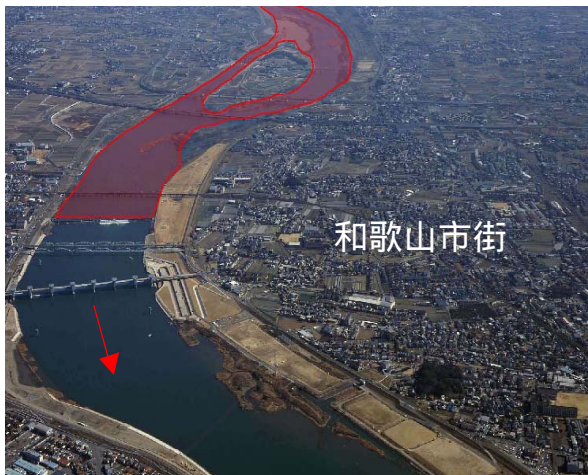
河道掘削による河積の確保
