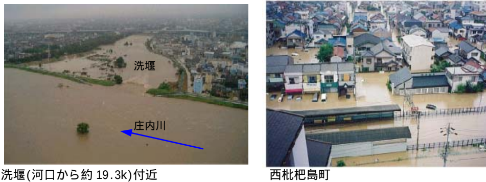
図 4 - 2 近年の洪水被害(平成 12 年 9 月洪水)
