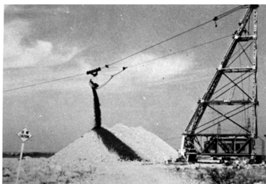
タワーエキスカベーター
