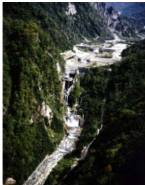
白岩砂防堰堤
