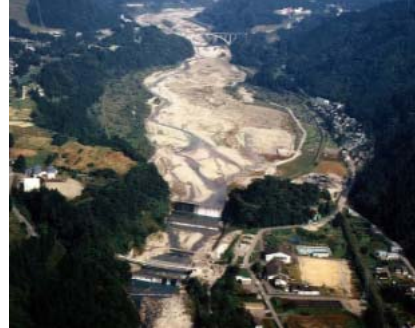
本宮砂防堰堤
