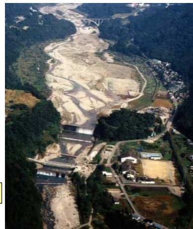
本宮砂防堰堤
