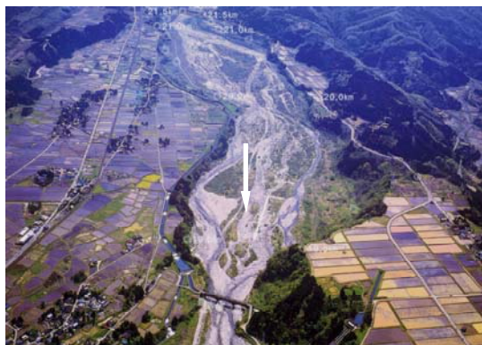
常願寺川扇頂部付近
