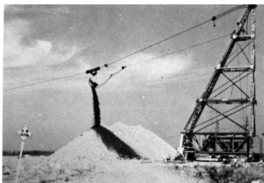
タワーエキスカベーター
