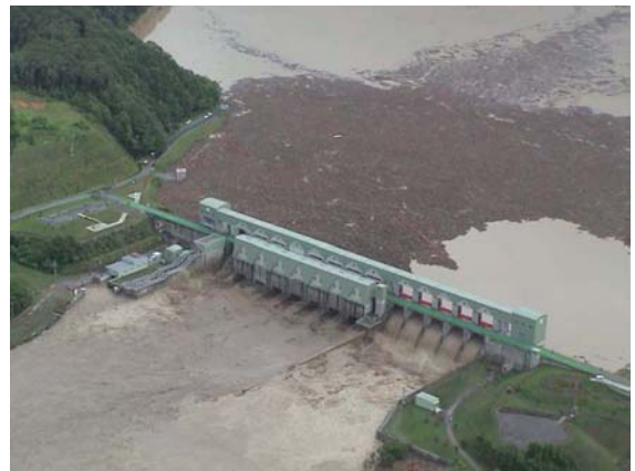
二風谷ダム下流から放流状況
