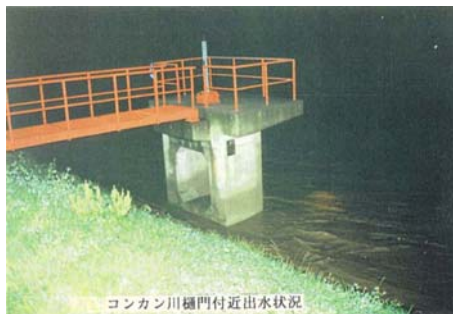
コンカン川樋門付近出水状況
