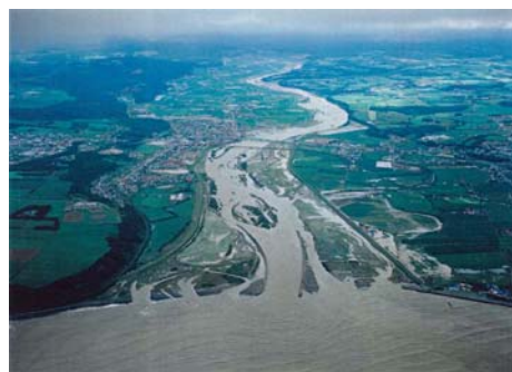
沙流川河口 出水状況
