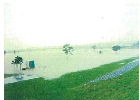
門別町せせらぎ公園浸水状況(河川公園)
