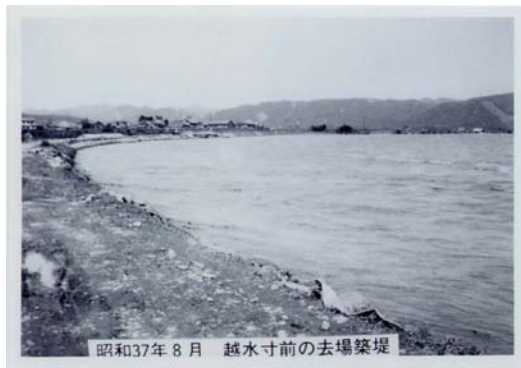
越水寸前の去場築堤
