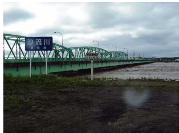
沙流川橋出水状況
