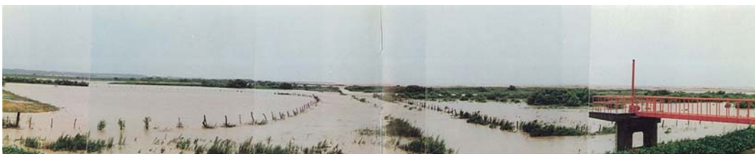
河口右岸 表町樋門外水氾濫
