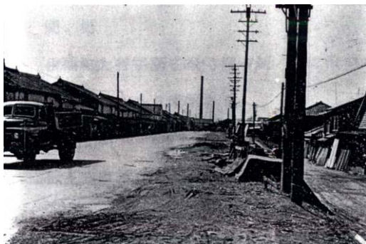
柳堤：嘉家作町付近 (現在 24 号国道)
