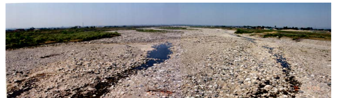
平成13年4月撮影（新常願寺橋（12.8k）下流部）
