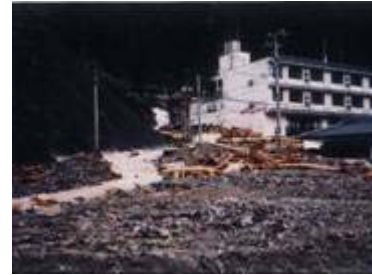
平成11年6月梅雨前線豪雨による被災 (吉野川中流域:祖谷川)
