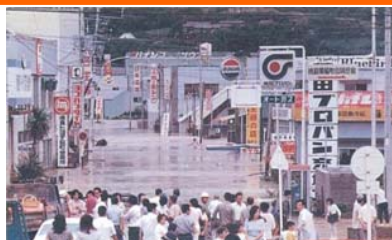
昭和49年9月洪水浸水状況(美馬市脇町)
