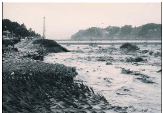
（右上写真）必死の水防活動で地域を水害から守った （右下写真）岩嶺野地先では洗掘により破堤した
