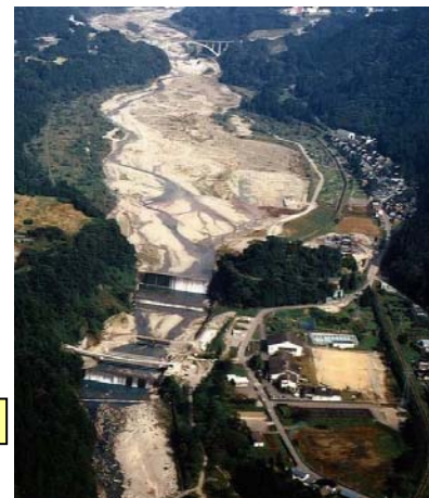
本宮砂防堰堤
