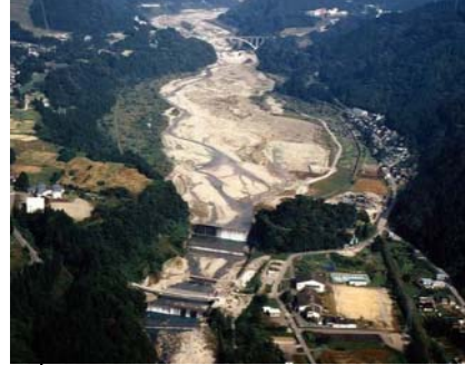
本宮砂防堰堤
