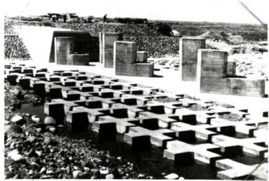
巨大水制群と根固工
