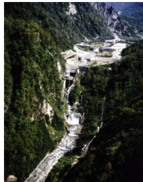
白岩砂防堰堤
