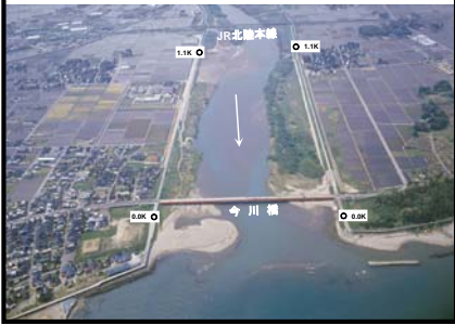
② 河口から3.1km付近
