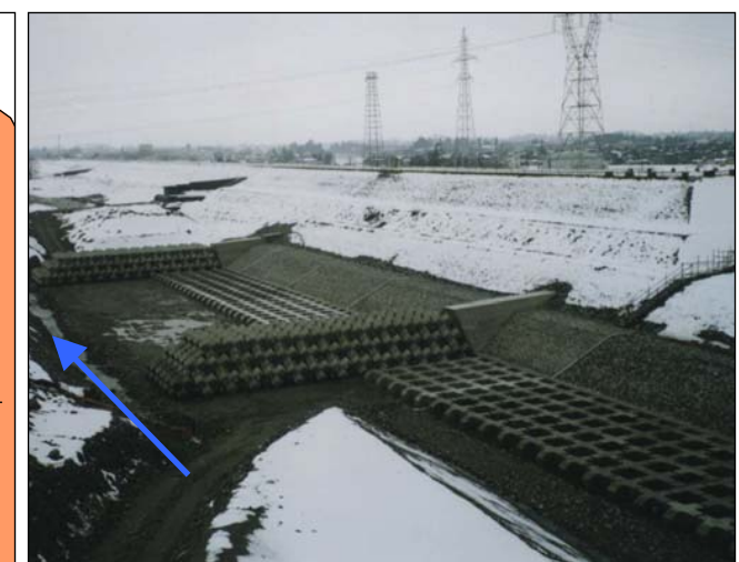
根継ぎ護岸工実施状況
