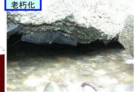
コンクリートの沈下、クラック、空洞化及び漏水が見られ、もし第十堰が壊れると、旧吉野川沿川の水利用に大きな支障を与えるおそれ
