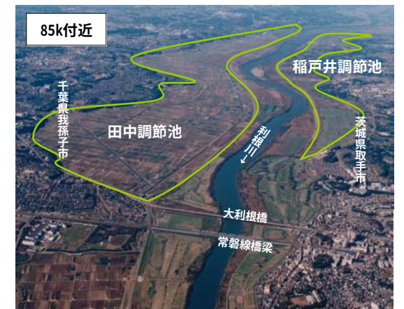
田中調節池・稲戸井調節池
