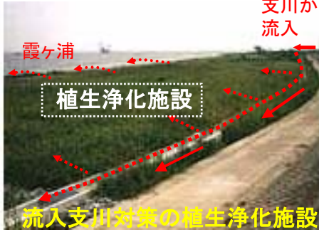
霞ヶ浦合流地点にヨシの浄化機能を活用した植生浄化施設を整備
