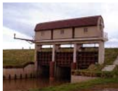
光ケーブル網・遠隔監視カメラで見た樋門 (CCTV)
