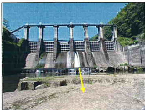
篠原ダム 最下流端の発電用ダム
