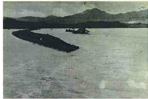
中州になった下郡築堤 (S28.6)
