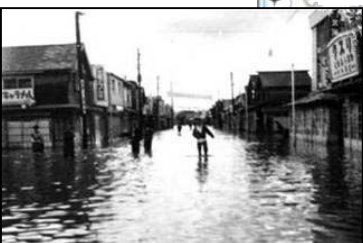
S37. 8の浸水状況
