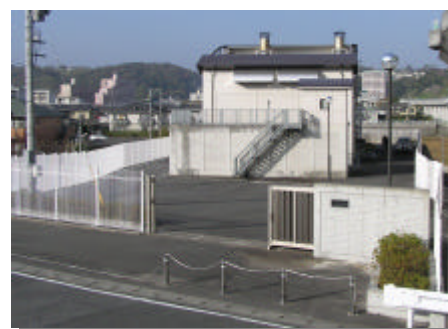
尼ヶ瀬排水機場
