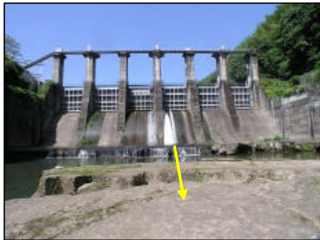
しのはら 篠原ダム 最下流端の発電用ダム
