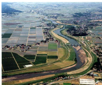
鳴瀬川中流堰(H14 完成)
