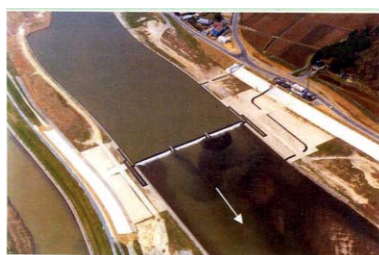
鳴瀬堰(H2 完成)
