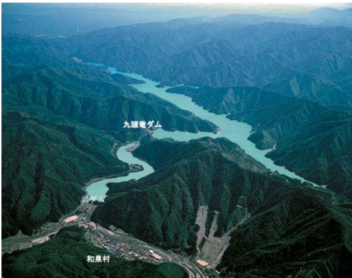
写真 2-1 九頭竜川上流 九頭竜ダム
