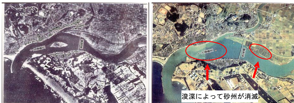
図4-2 昭和30年代以降の河道浚渫
