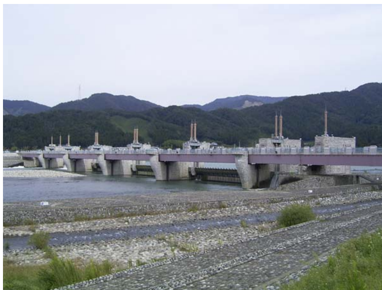
九頭竜川鳴鹿大堰
