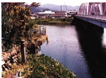
鳴鹿の渡し場跡（永平寺町）
