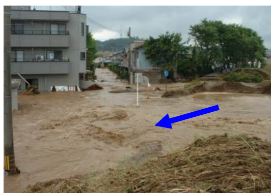
破堤部の状況（福井市春日）
