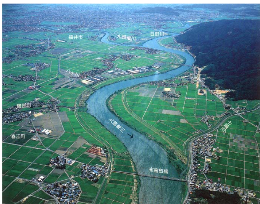
図 8-10 布施田橋付近
