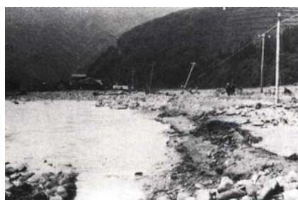
大野郡和泉村朝日付近の被災状況
