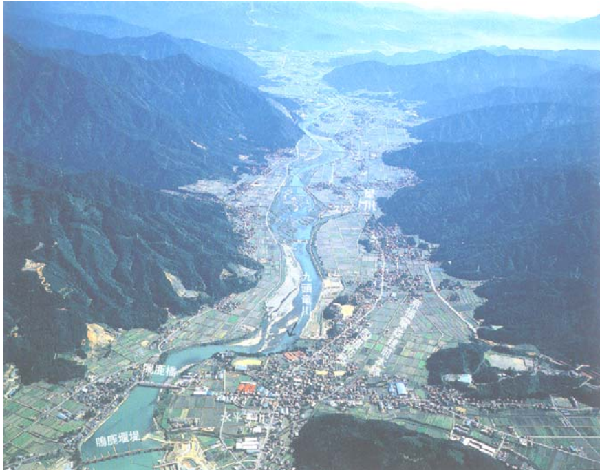
図 8-7 鳴鹿大堰付近
