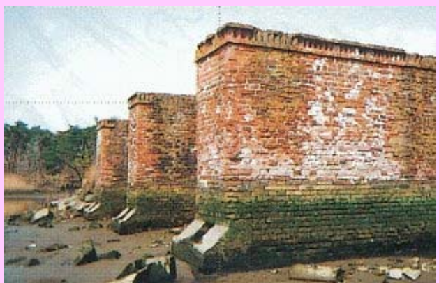
明治時代に計画された野蒜築港の跡(往時のレンガ造りの橋脚) [土木学会選奨土木遺産に選定]
