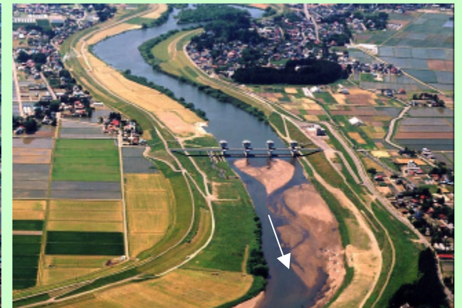
桑折江堰 (H15完成) 河床安定と農業用水の確保を目的に設置 ＊農水省との共同事業により建設
