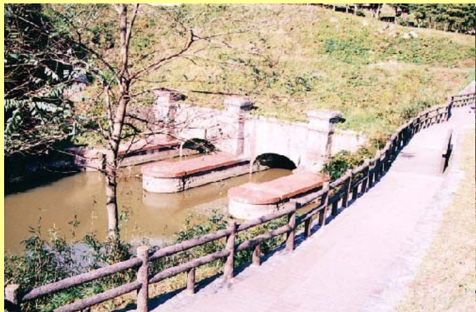
洪水防御のため明治潜穴を開削(1910年) [土木学会近代土木遺産2000選に選定]
