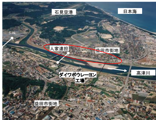
高津川下流部 益田市街地の状況
