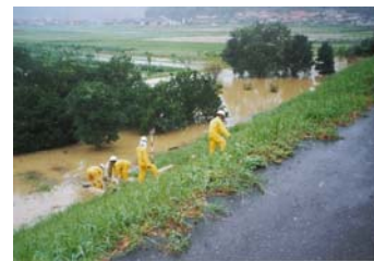
平成9年7月洪水による 被災状況
