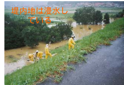
堤防や基盤からの漏水の状況 (平成 9 年 7 月洪水)
