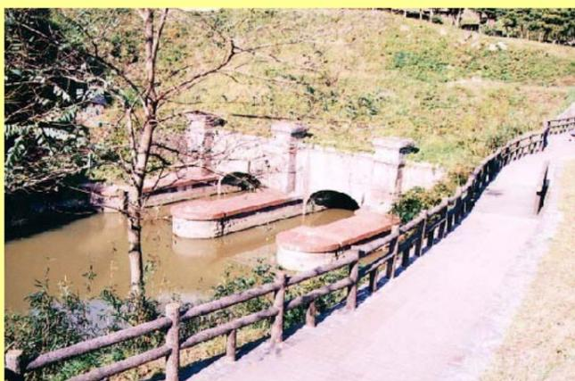
洪水防御のため明治潜穴を開削(1910年)
