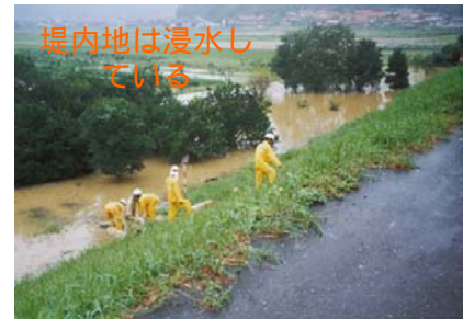
堤内地は浸水している 堤防や基盤からの漏水の状況 (平成 9 年 7 月洪水)
