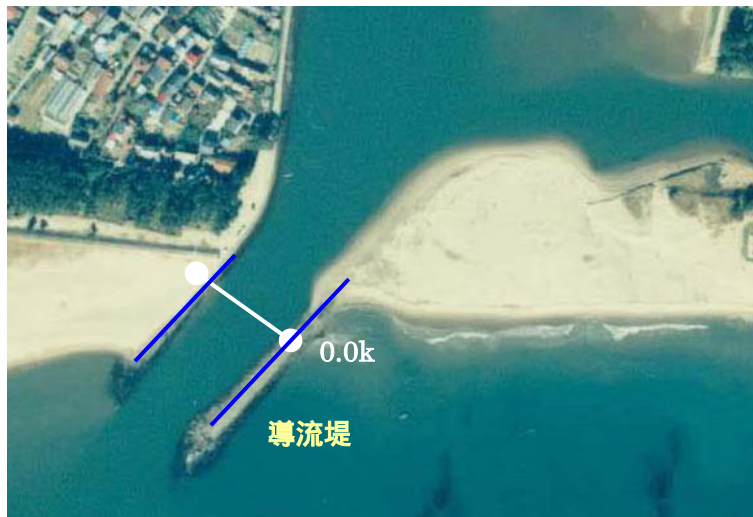
図 3-2 平面図 (平成 10 年撮影) [導流堤 : M15 完成]
