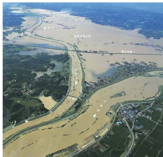
吉田川の破堤氾濫状況
