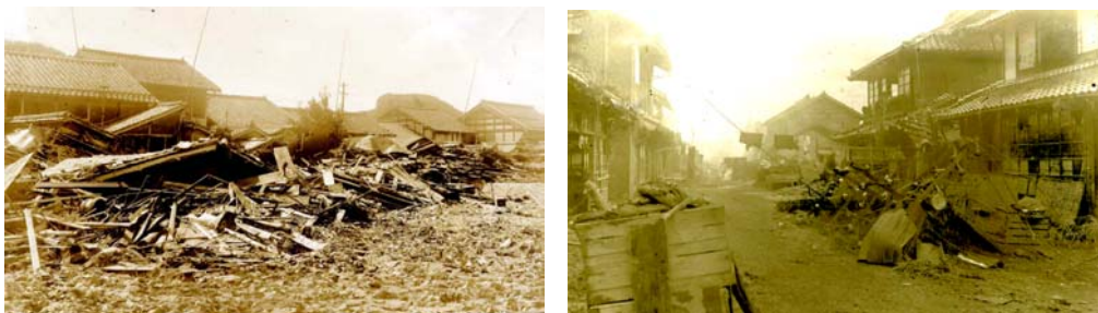
図-4.5 高津川・益田川が破堤氾濫(昭和 18 年 9 月洪水)
