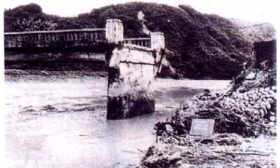
S47.7 洪水(S47.7 豪雨)の 被災状況写真
