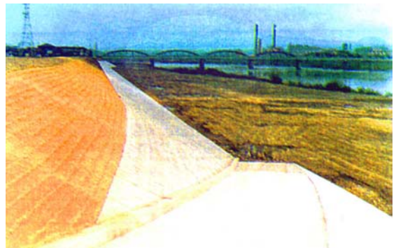
図-4.12 高津地区護岸の施工状況(S54)
