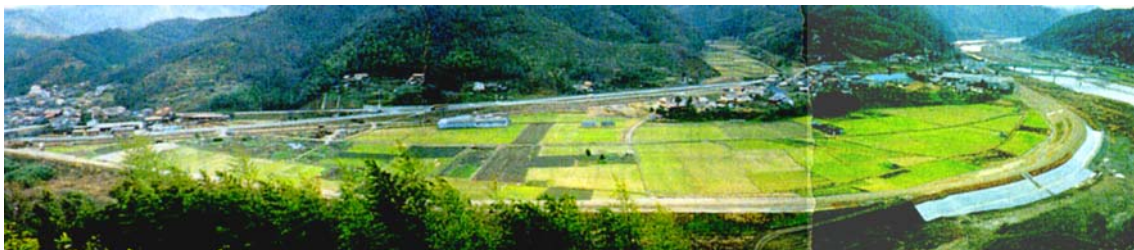
神田地区引堤工事
