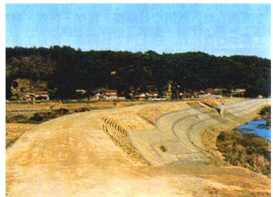
図-4.13 白上川堤防の施工状況(S55)
