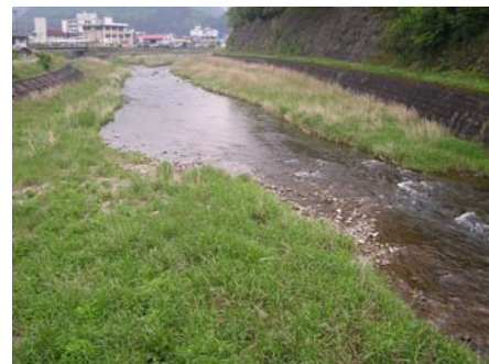
図-2.11 吉賀町六日市新抜月橋上流方面
