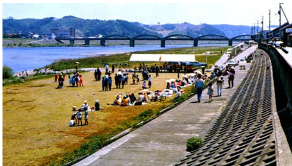
図-2.17 高角橋下流の高水敷の利用状況
