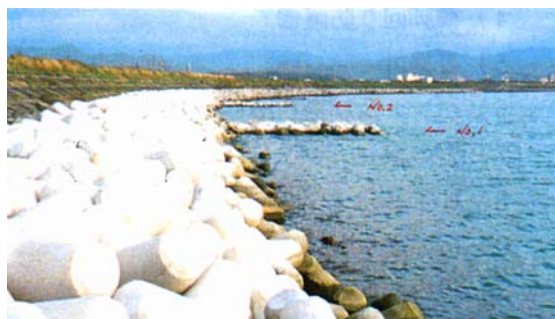
中の島水制工事
