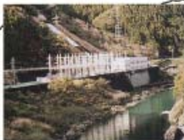
日野谷発電所 ・ 位置／那賀町日南
