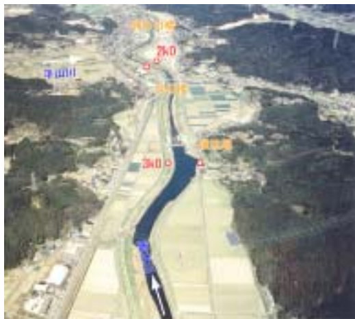
【厳木川横枕堰付近】
