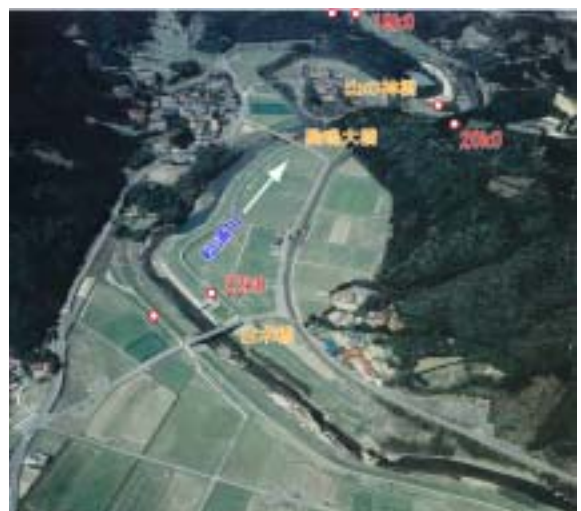
【22k0 付近の河道の状況】
