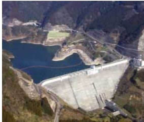
【厳木ダム本体】
