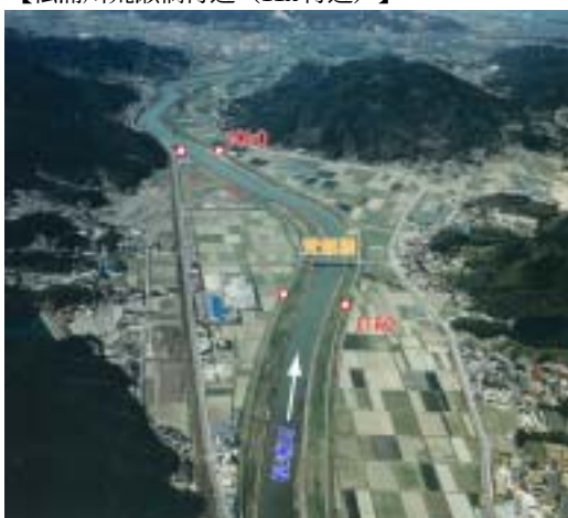
【松浦川荒瀬橋付近（11k 付近）】
