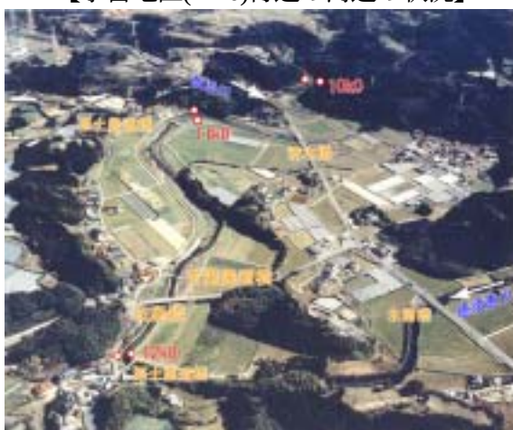
【水留地区(12k0)付近の河道の状況】
