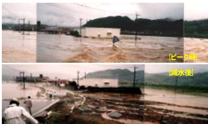
【松浦川 川西橋下流(25k000 付近)】
