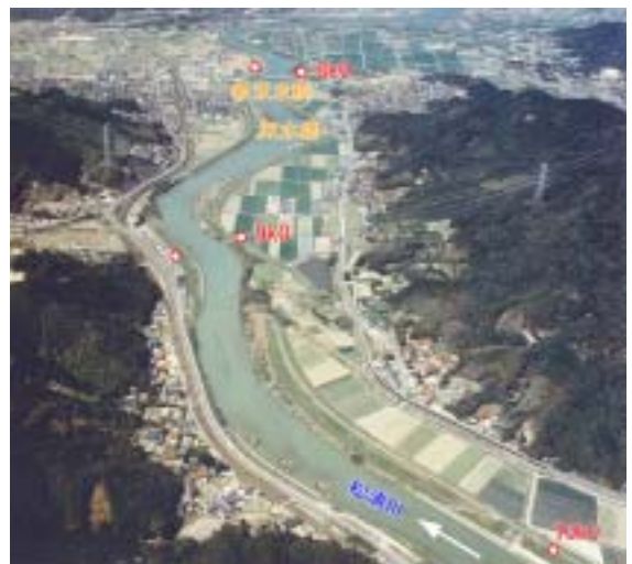
【9k0 付近の河道の状況】
