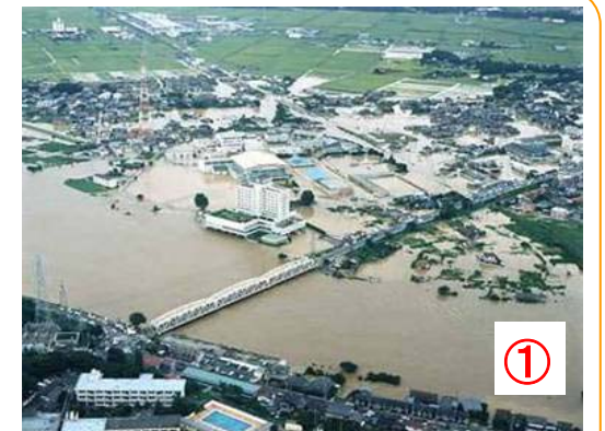
▲洪水時の水府橋周辺（水戸市）
