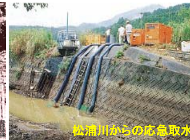
松浦川からの応急取水 H6渇水(伊万里市)
