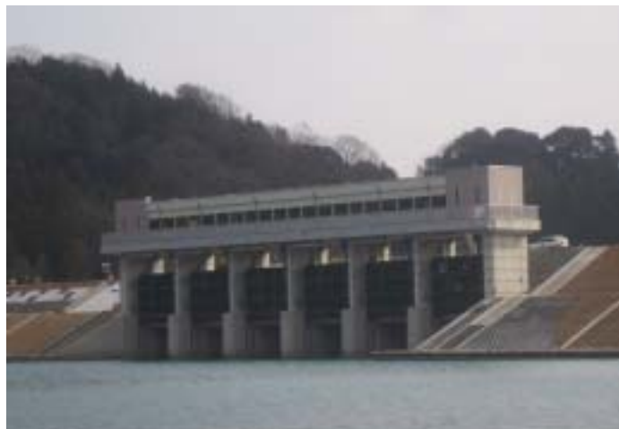
熊谷川樋門（吉井箇所改修事業）
