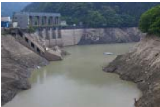
長安口ダム（平成17年春～夏渇水）
