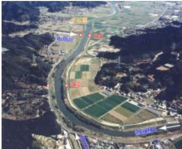
【田中川合流点付近の河道の状況】
