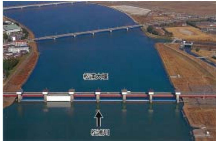
【松浦大堰本体】
