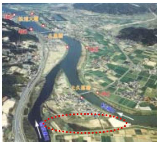
【松浦川合流点旧川地区付近】
