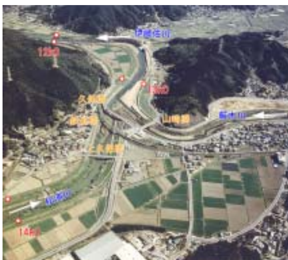
【厳木川合流点付近の河道の状況】
