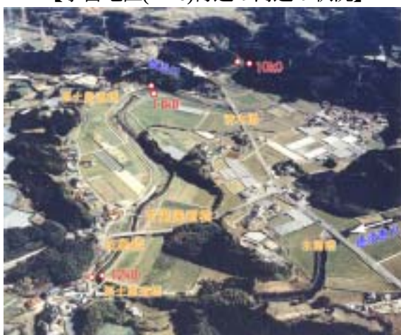
【水留地区(12k0)付近の河道の状況】
