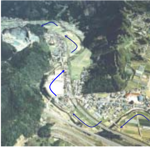
【厳木川 10k0 付近の蛇行状況】
