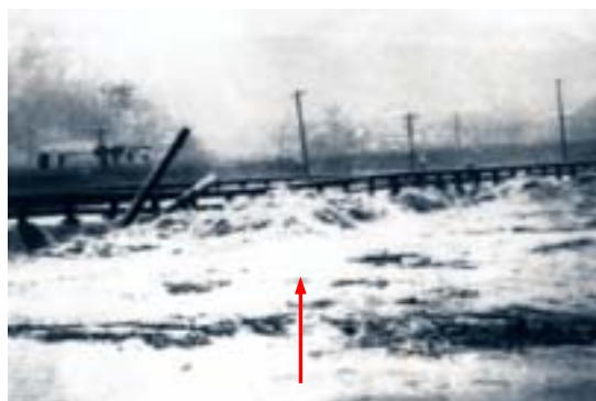
【厳木川 厳木橋(9k900 付近)】
