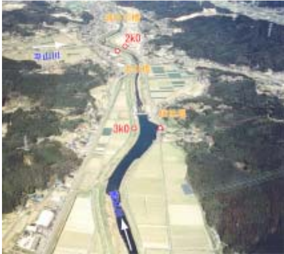
【横枕堰付近の河道の状況】
