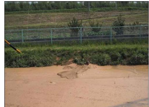
漏水状況（右岸 38.8k 付近）
