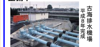
古海排水機場 平成8年完成
