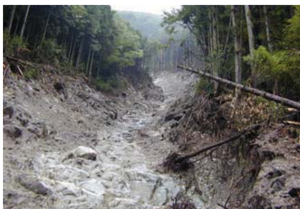
上村川沿川の沢抜け(旧上矢作町)
