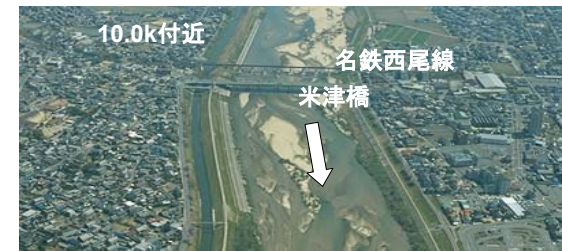
両岸の堤防沿いの市街化の状況
