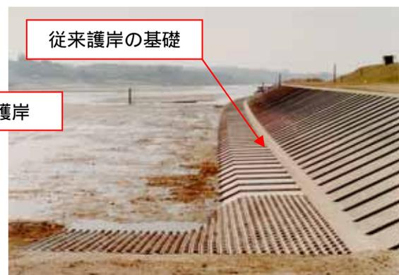
また、砂河川の矢作川では、河床低下対策として、洗堀される恐れのあるコンクリートブロック根固め工法に替わり、屈とう性がよく、堤防法面と馴染みのよい柳枝工を古くから施工してきた。
