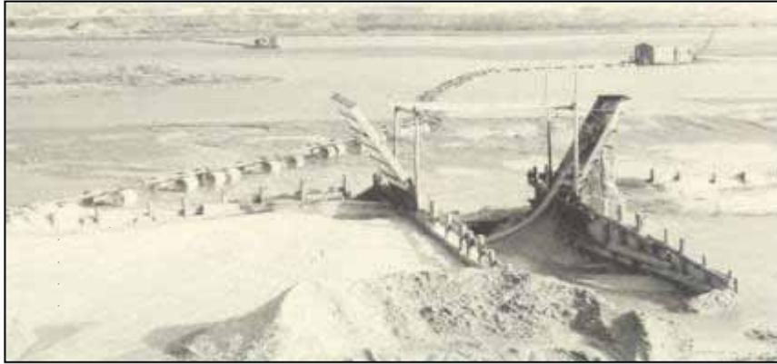
砂利採取の風景（サンドポンプでの川砂利採取）（昭和 45 年・西尾市）
